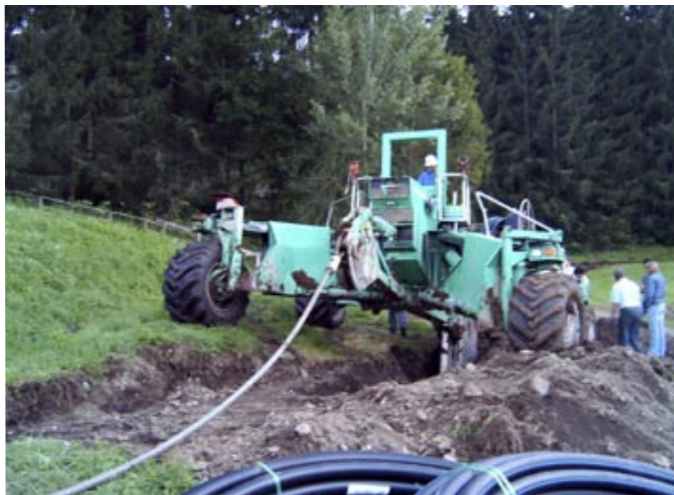
Unsere Gemeindegänger beim Wasseranschlußbau
