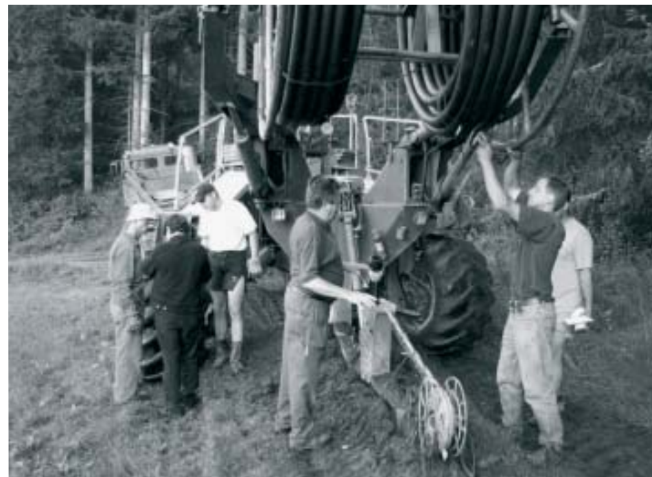
Unsere Gemeindearbeiter beim Wasseranschlußbau
